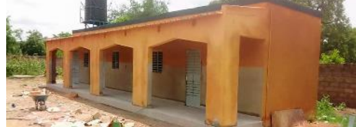
Bestaande slaapzaal voor en na de opknapbeurt
